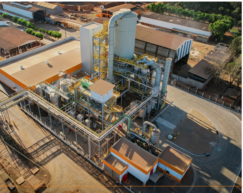
UISA BIONUTRITION, CONSTRUÇÃO CONCLUÍDA
